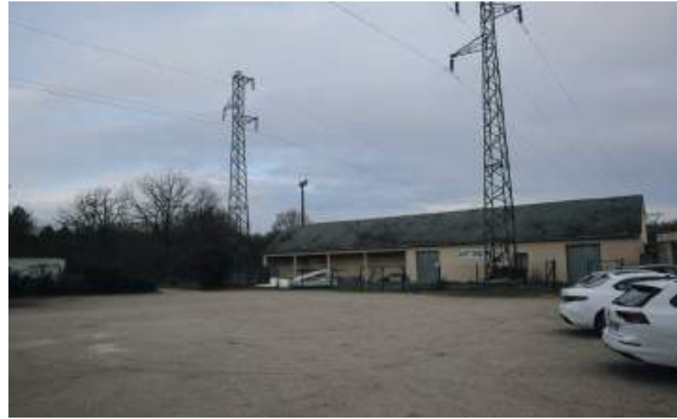
5. Le bâtiment existant avec les lignes HTA
