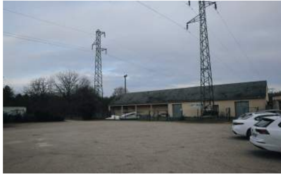
5. Le bâtiment existant avec les lignes HTA
